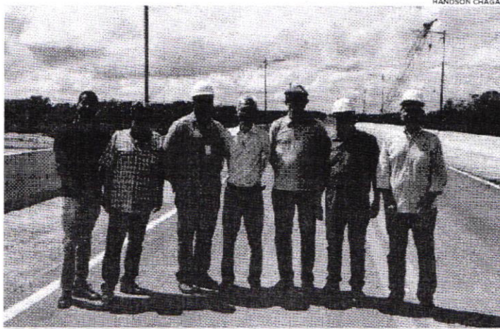
Durante vistoria, secretários conferiram o andamento dos serviços na Ponte Central-Bequimão
