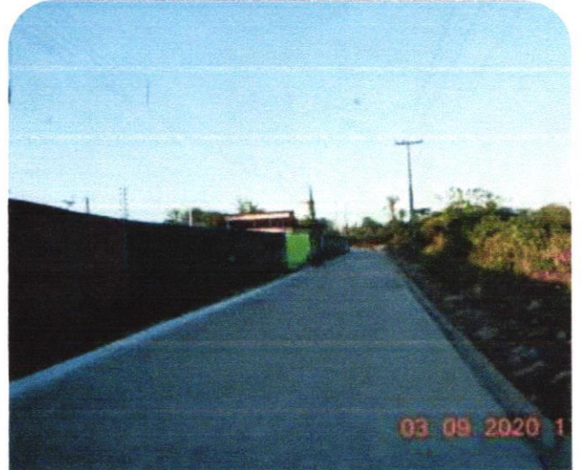
Pavimentação de Blokret, Bairro Cohab 2 no Município de Rosário/MA
