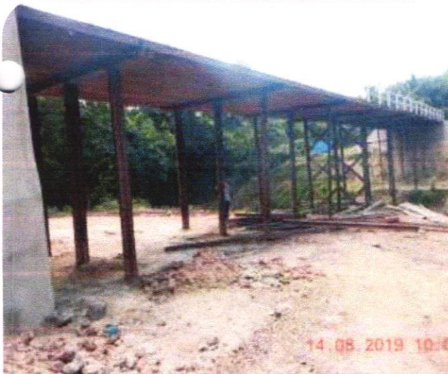
Ponte de Trilho no Povoado Piqui em Itapecuru Mirim/MA
