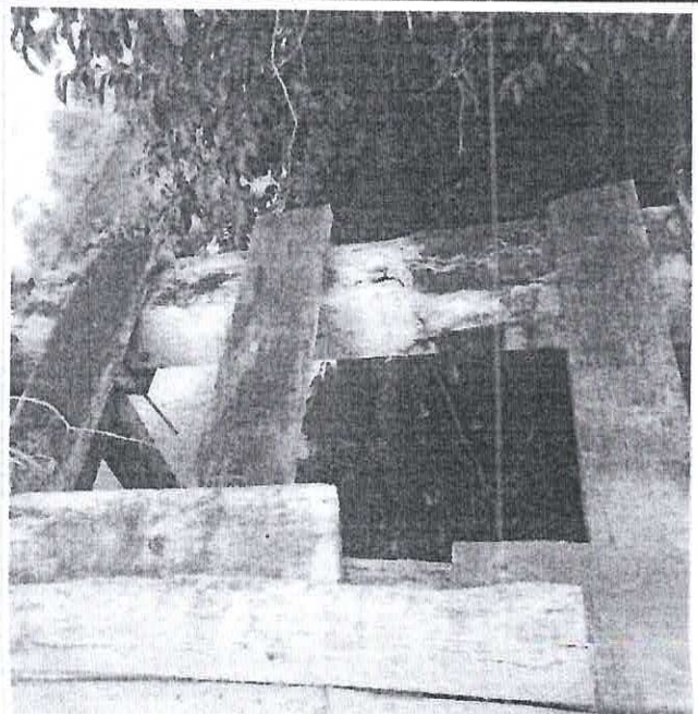
LOCAL PONTE SOBRE O IGARAPÉ DA QD. XXIV
