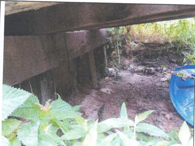
LOCAL PONTE SOBRE O IGARAPE DA RUA 8 DE JULHO
