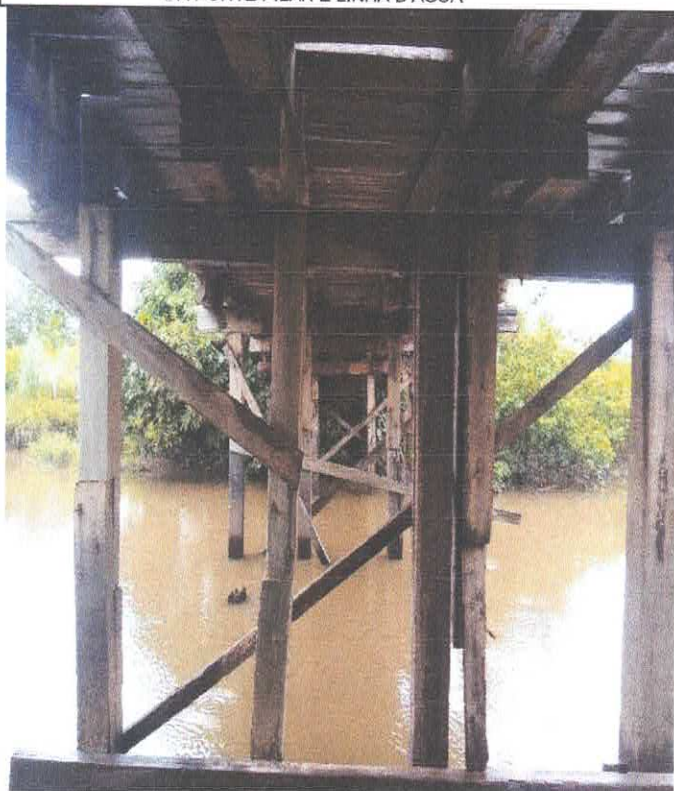
LOCAL PONTE SOBRE O IGARAPÉ DO TRACUÁ RUA STª LUZIA
