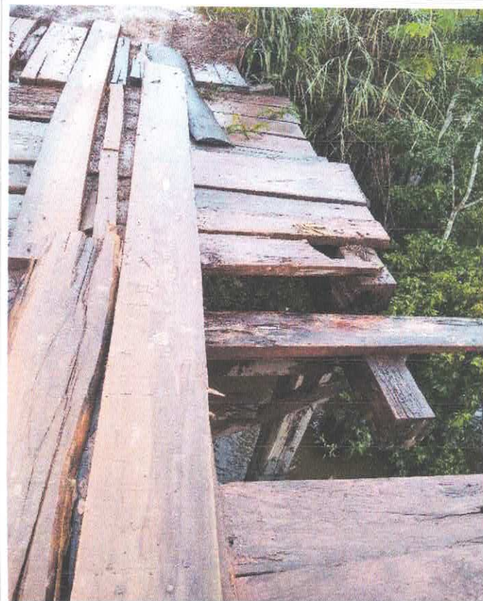
LOCAL PONTE SOBRE O IGARAPÉ DO TRACUÁ RUA STª LUZIA
