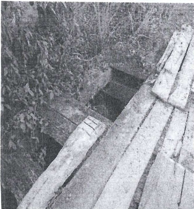
LOCAL PONTE SOBRE O IGARAPÉ DA QD. XXIV
