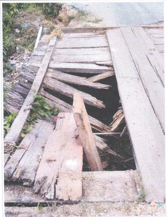
LOCAL PONTE SOBRE O IGARAPÉ DA RUA 8 DE JULHO
