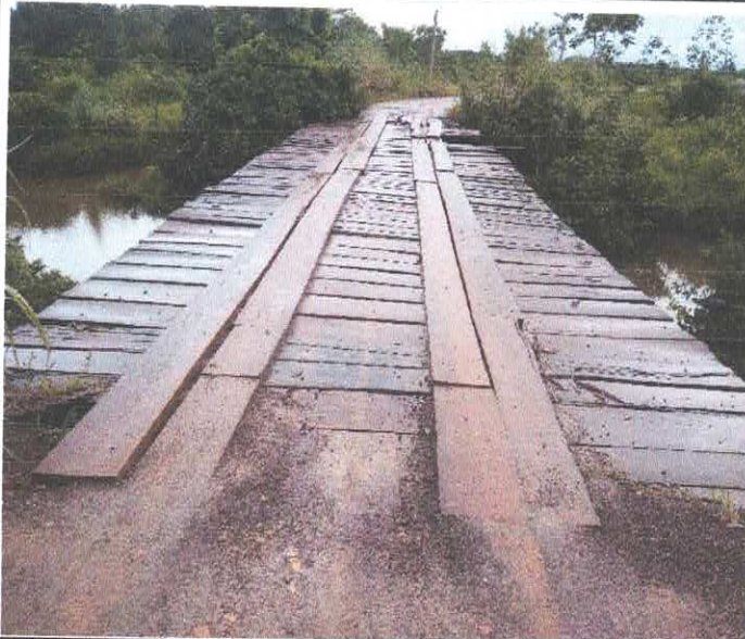
LOCAL PONTE SOBRE O IGARAPÉ DO TRACUÁ RUA STª LUZIA
