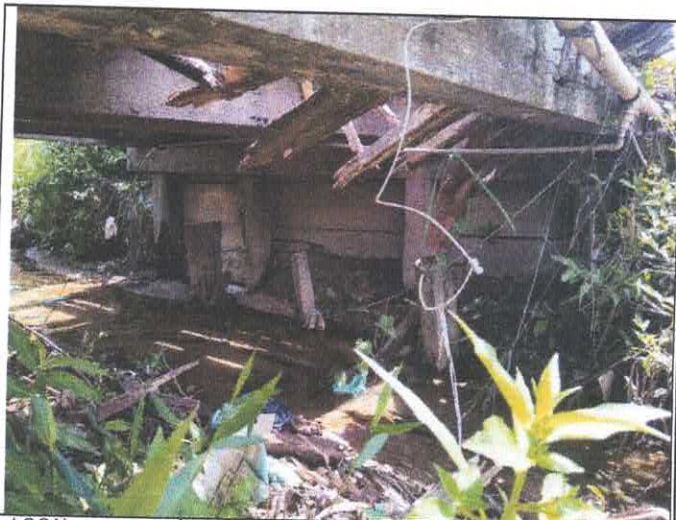
LOCAL PONTE SOBRE O IGARAPE DA RUA 8 DE JULHO
