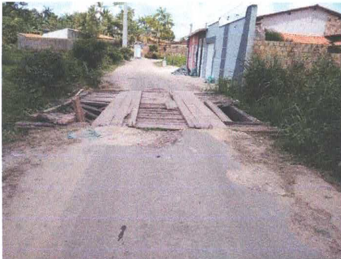
LOCAL PONTE SOBRE O IGARAPÉ DA RUA 8 DE JULHO
