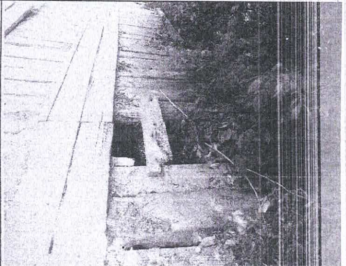
LOCAL PONTE SOBRE O IGARAPÉ DO JUÇARAL
