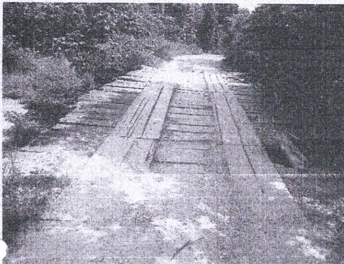
LOCAL PONTE SOBRE O IGARAPÉ DO JUÇARAL
